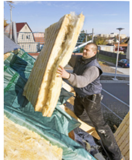
Sparpotenziale Die KfW fördert die Wärmedämmung von Dächern
