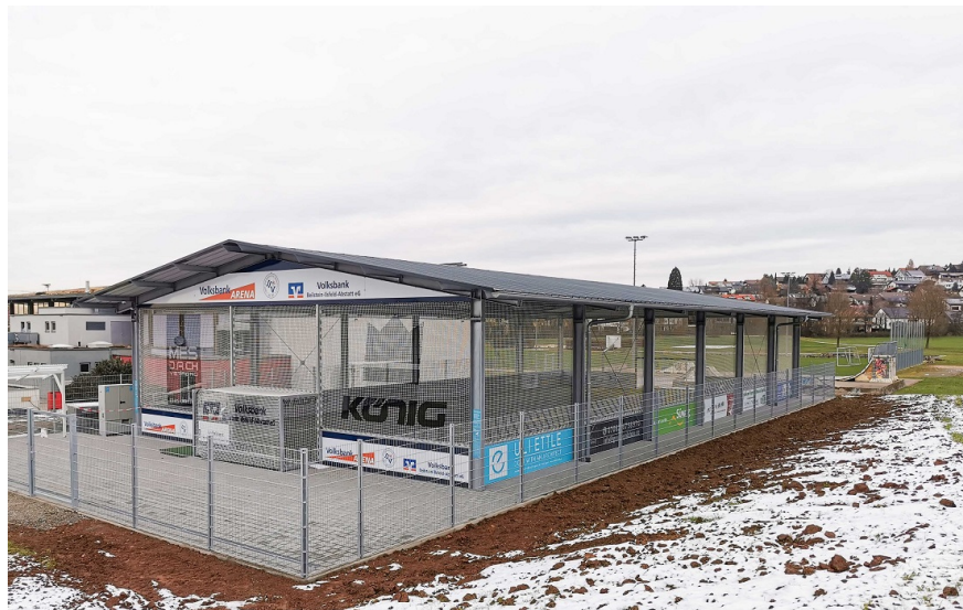
Volksbank Arena des SSV Auenstein (Hersteller: Fa. MC Arena)
